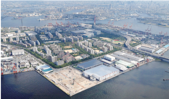
左下の敷地で2期工事を実施する。その右側手前が建設中の1期施設
